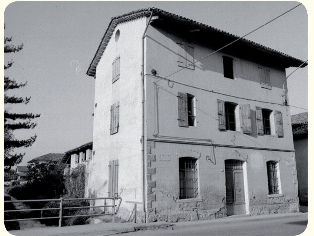
Il mulino, com'era prima di essere trasformato in edificio d'abitazione. Foto ERPAC Friuli Venezia Giulia.
