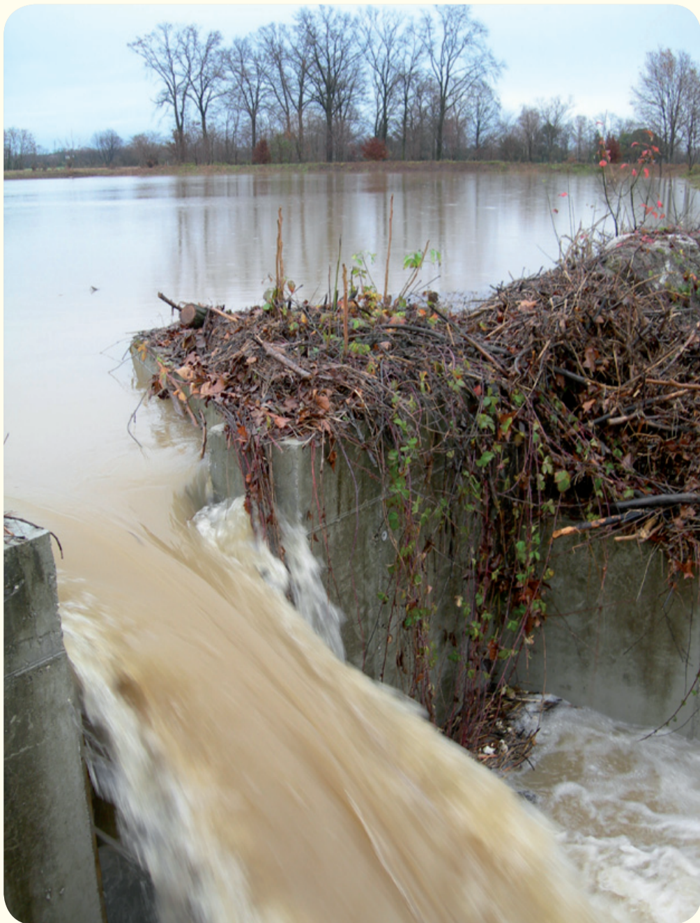
La paratia di uscita dell'ultima cassa di laminazione durante una piena eccezionale.
